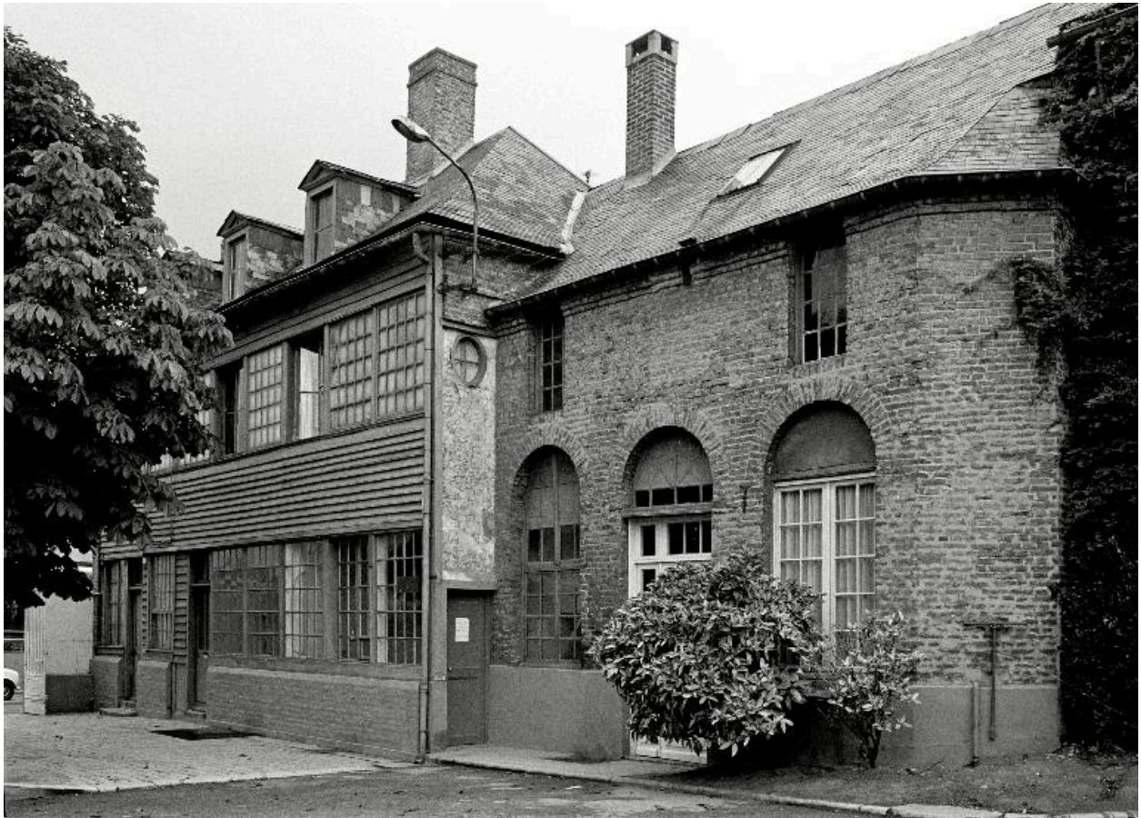
Elévation antérieur de la conciergerie, en 1990.
