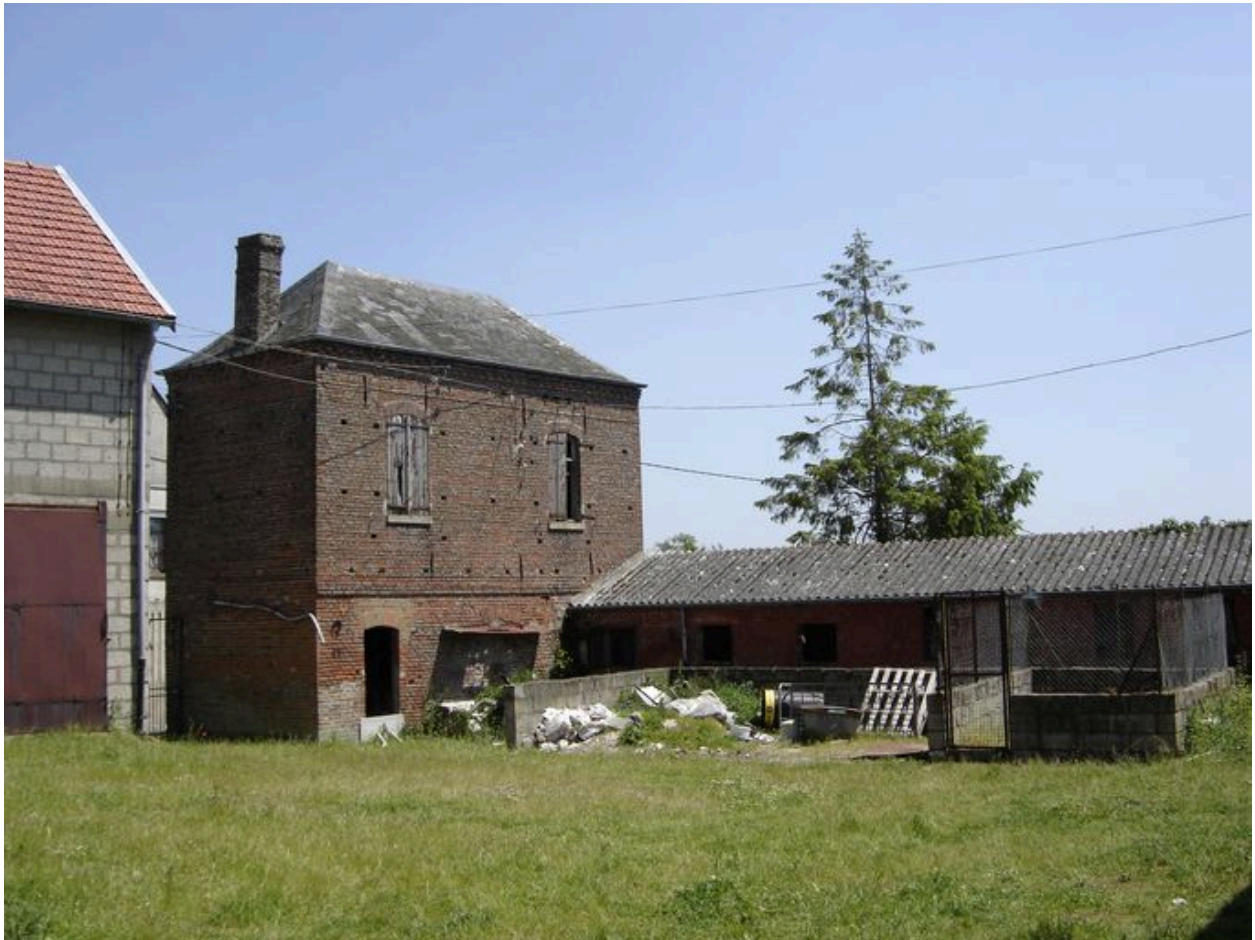
Vue postérieure de l'ancien établissement.
