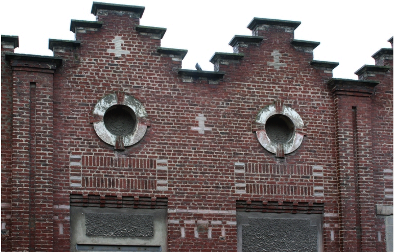
Façade des ateliers de 1921 : détail.
