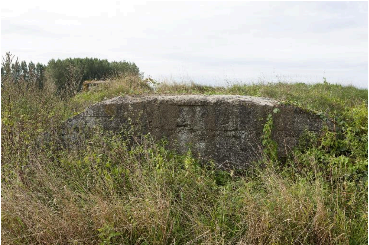
Vue latérale, vers sud-ouest
