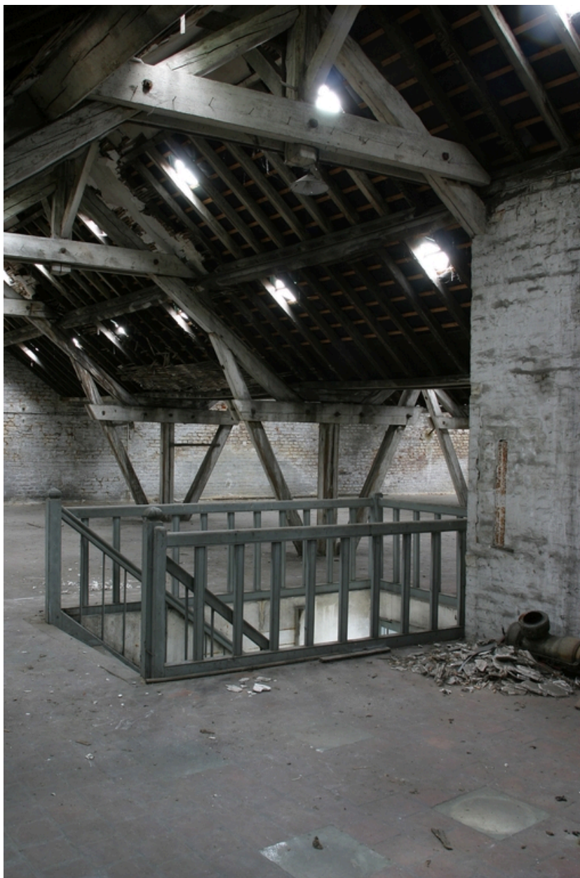
Combles de l'atelier de 1900 : ancien atelier de réparation en 1914.
