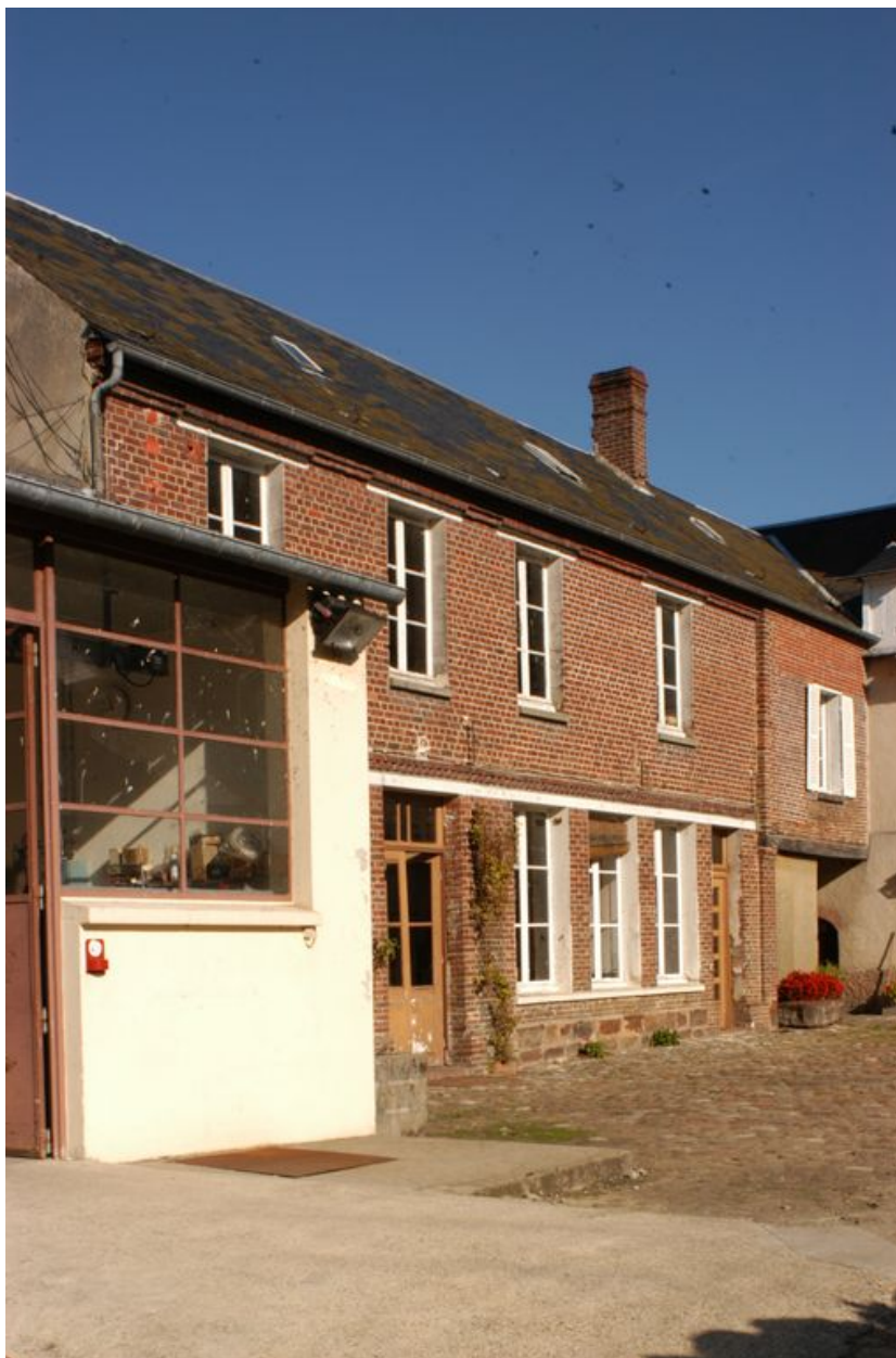
Les bureaux construits vers 1920.
