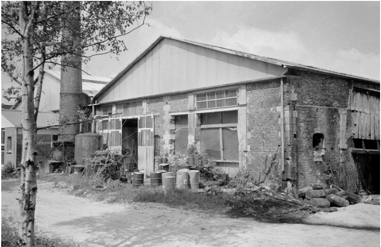
Atelier de fabrication : flanc est.
