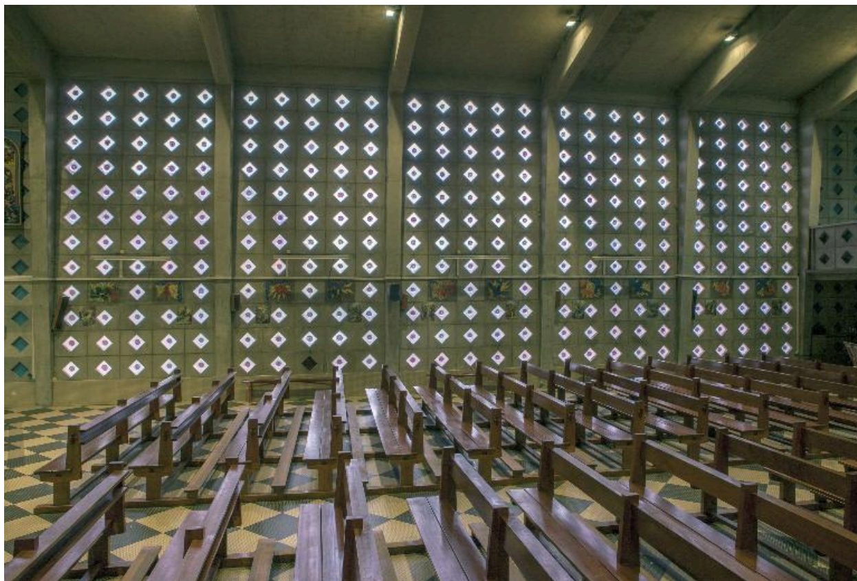
Claustras du mur intérieur, côté droit.
