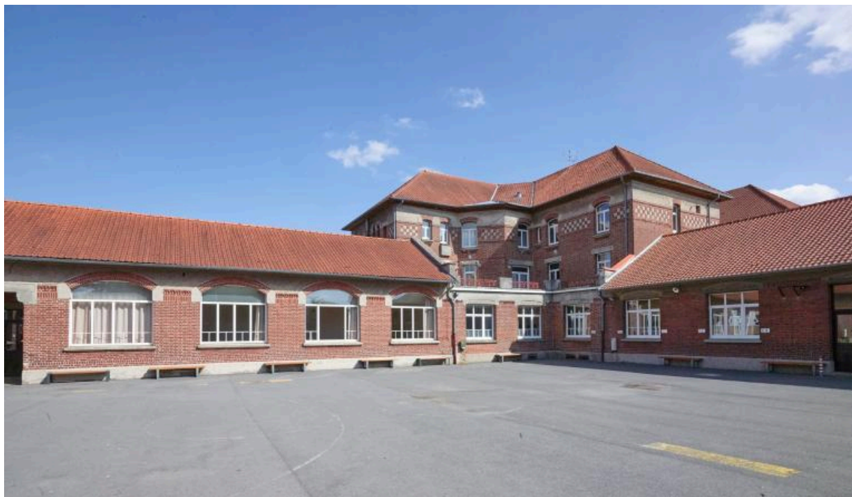
Ecole Carlin, vue du pavillon et des classes depuis la cour.
