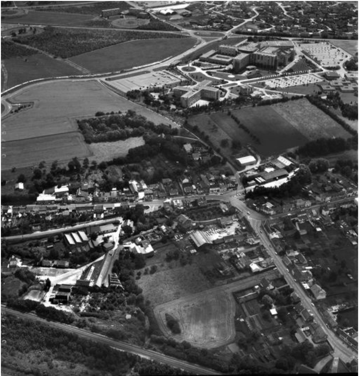
Vue aérienne, flanc nord-ouest.
