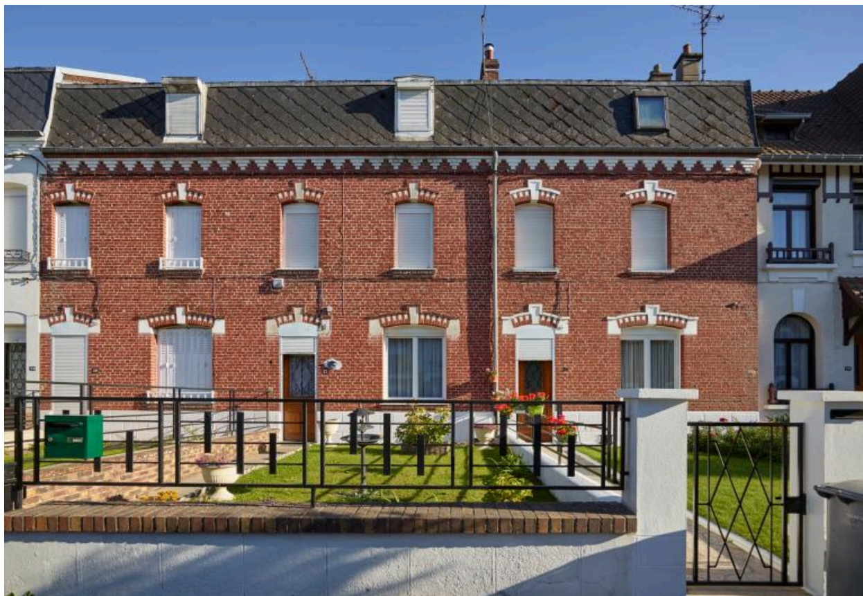
Maison à 3 unités d'habitation, n° 33-35-37 rue de la République. Vue des façades principales. Construites en 1922 par Eugène Bidard, pour Mme Christine-marie Cilliez-Sorand. Décor de frise en briques blanches sous la corniche et sur les linteaux. pour Mme
