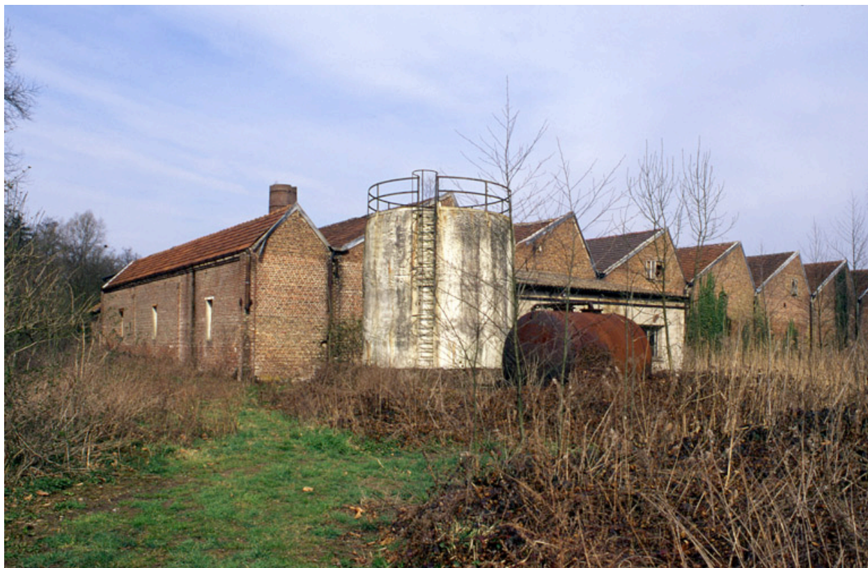
Vue partielle sud-est de l'atelier de fabrication et d'un réservoir industriel.
