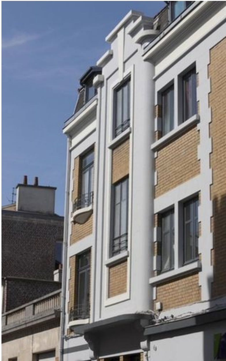
Oriel situé sur la façade rue du Général-Barbot.
