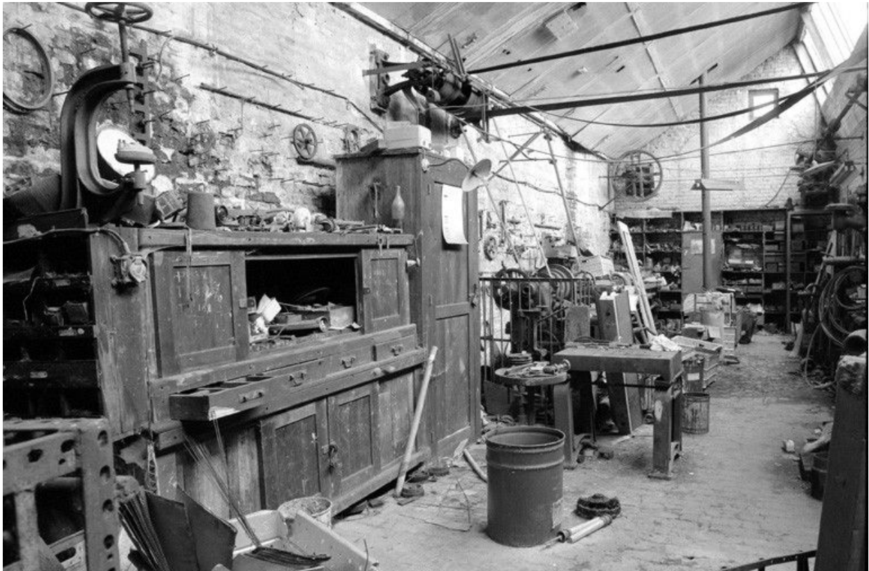
Atelier de réparation, vue intérieure.
