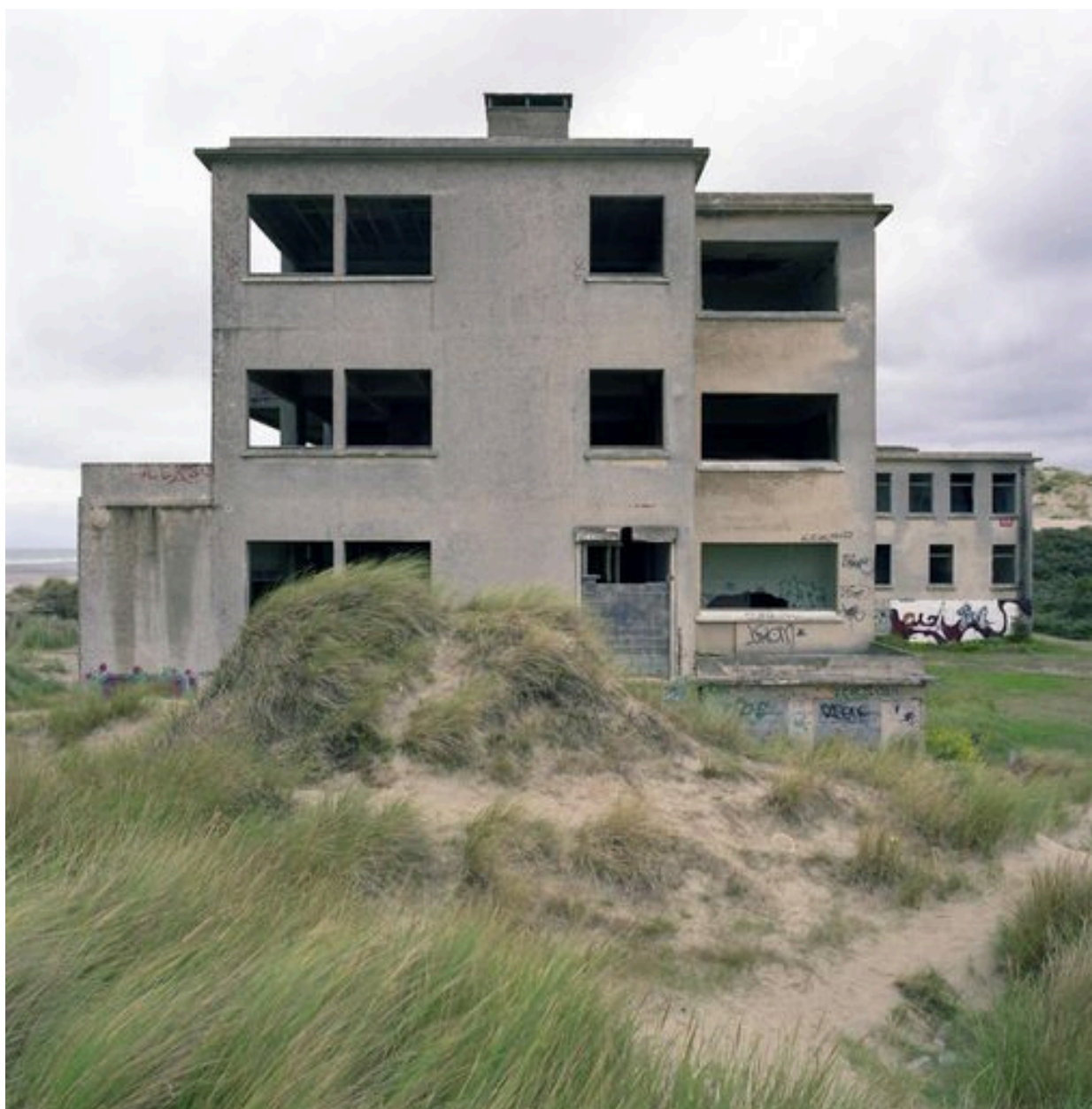
Elévation latérale sud, vue générale.
