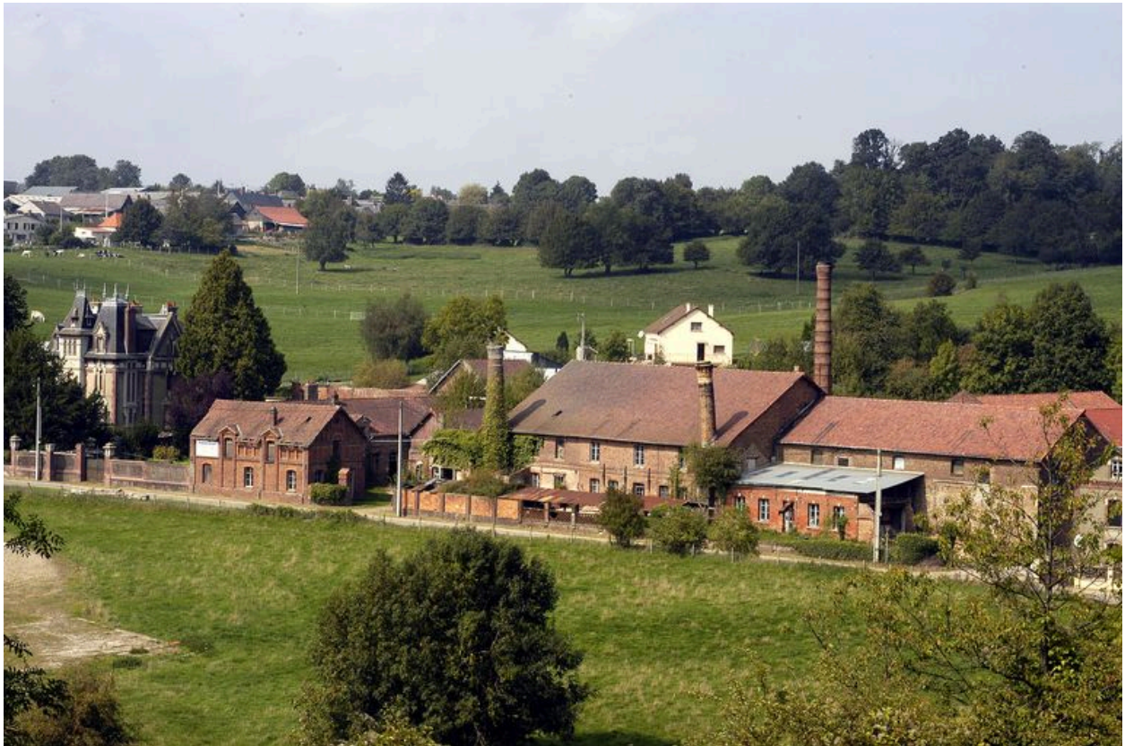
Vue d'ensemble du site industriel.
