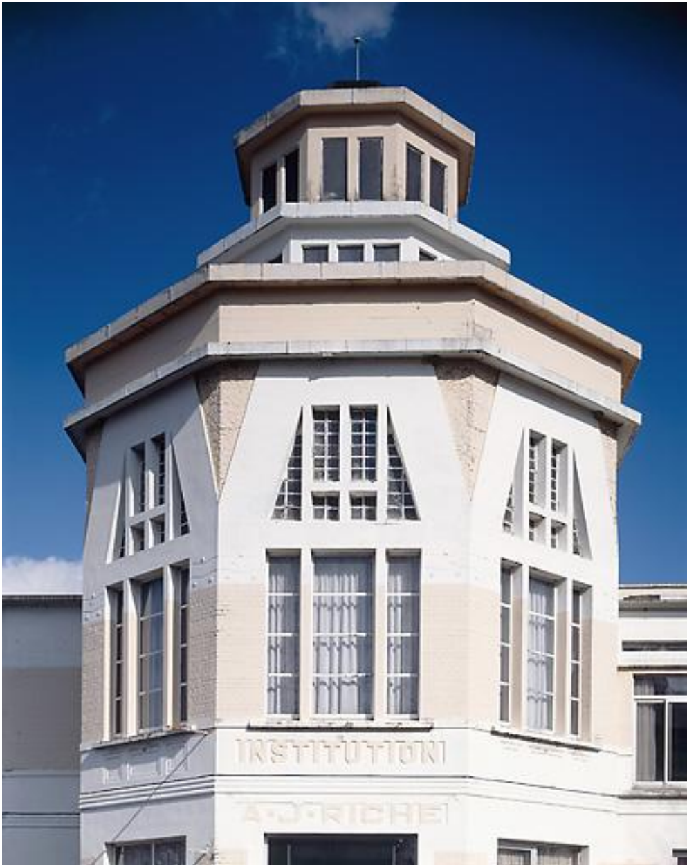
Élévation antérieure du hall d'accueil.
