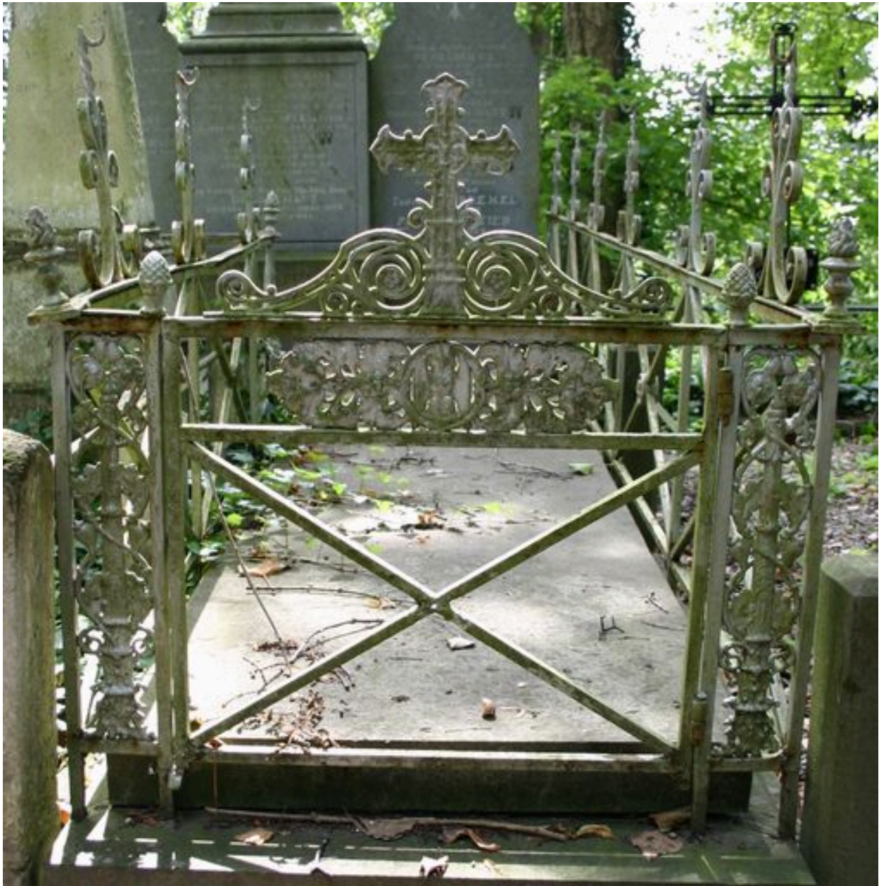
Portillon de clôture.
