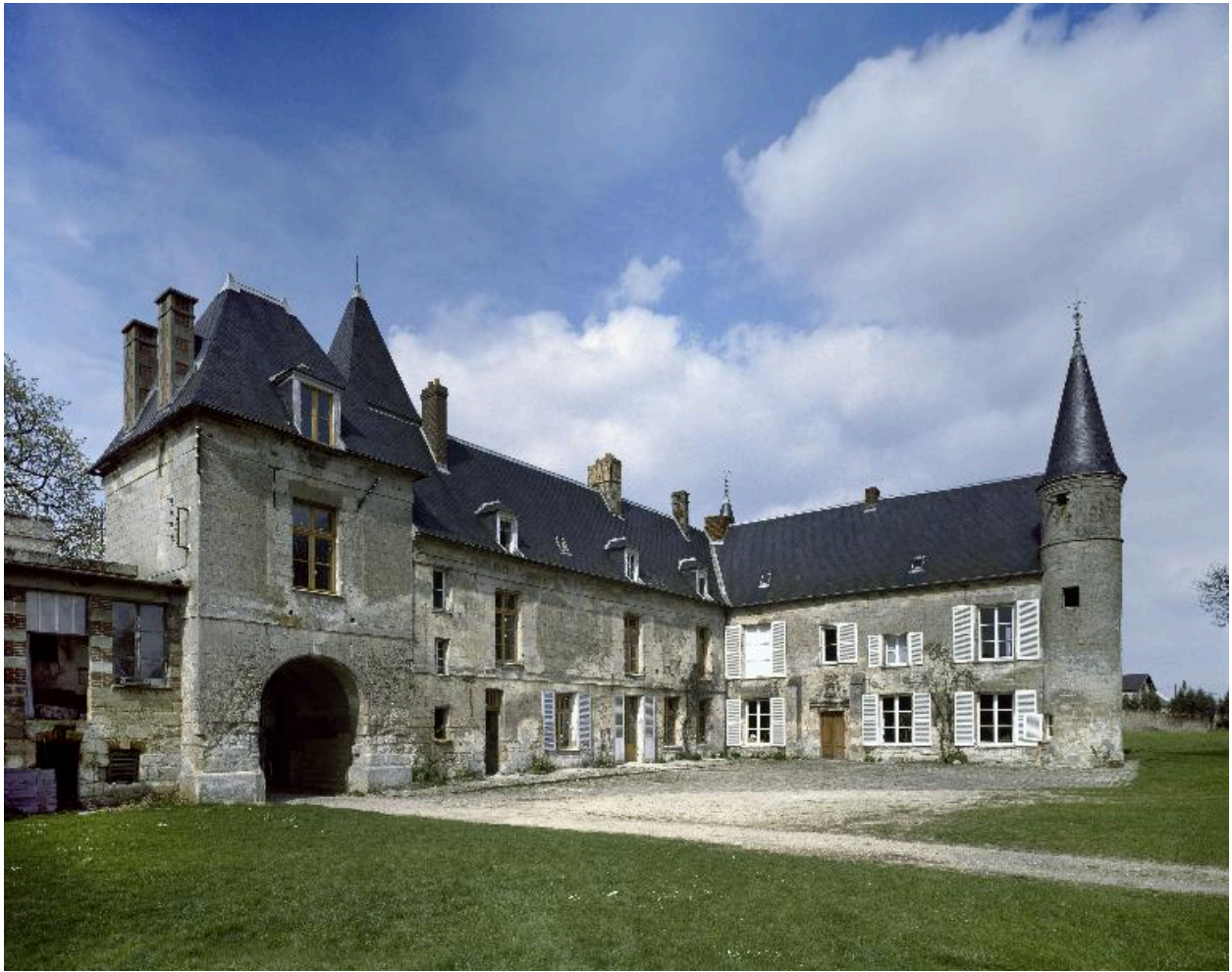
Vue des élévations sur cour du logis et de l'ouvrage d'entrée.
