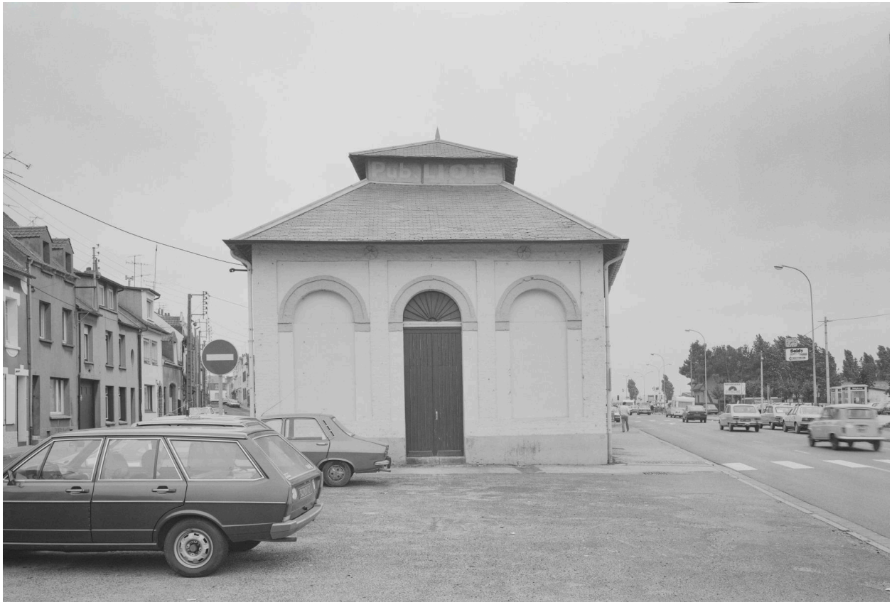
Vue latérale prise depuis le nord-ouest.
