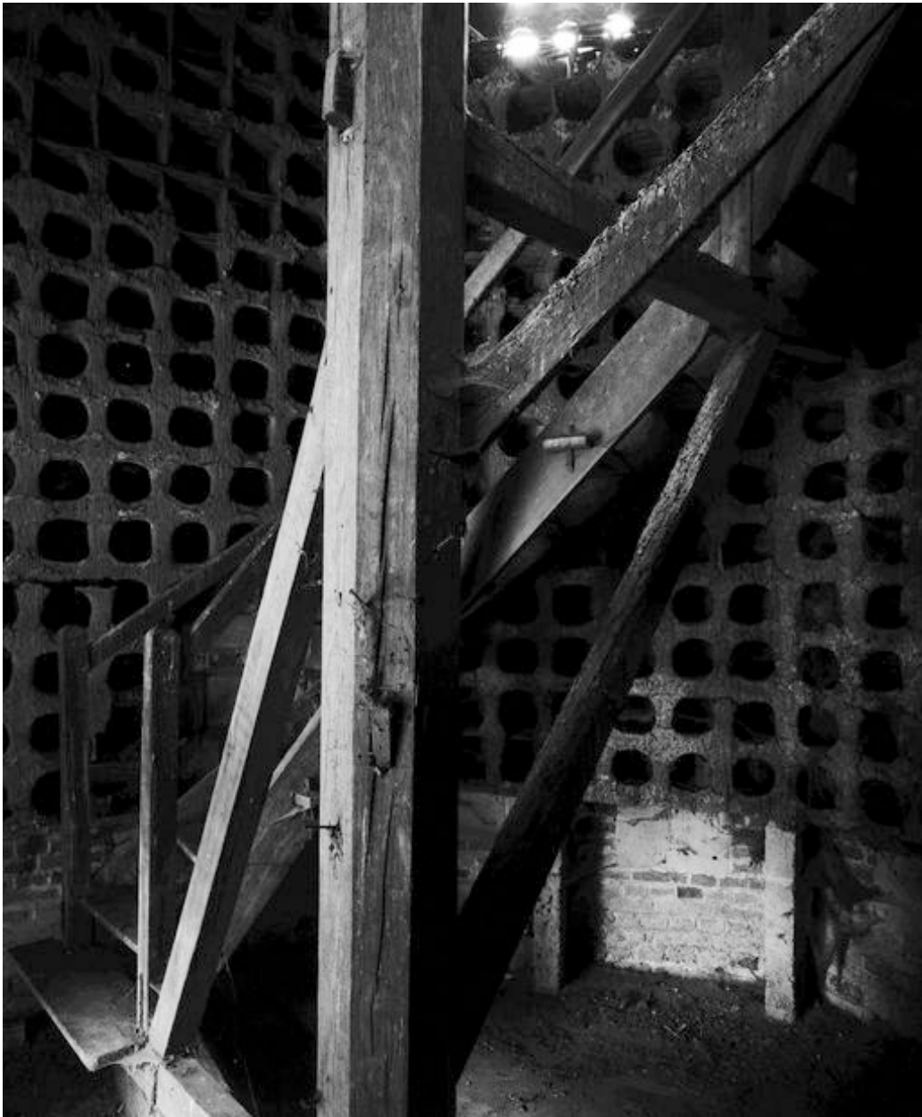
Colombier. Vue intérieure.
