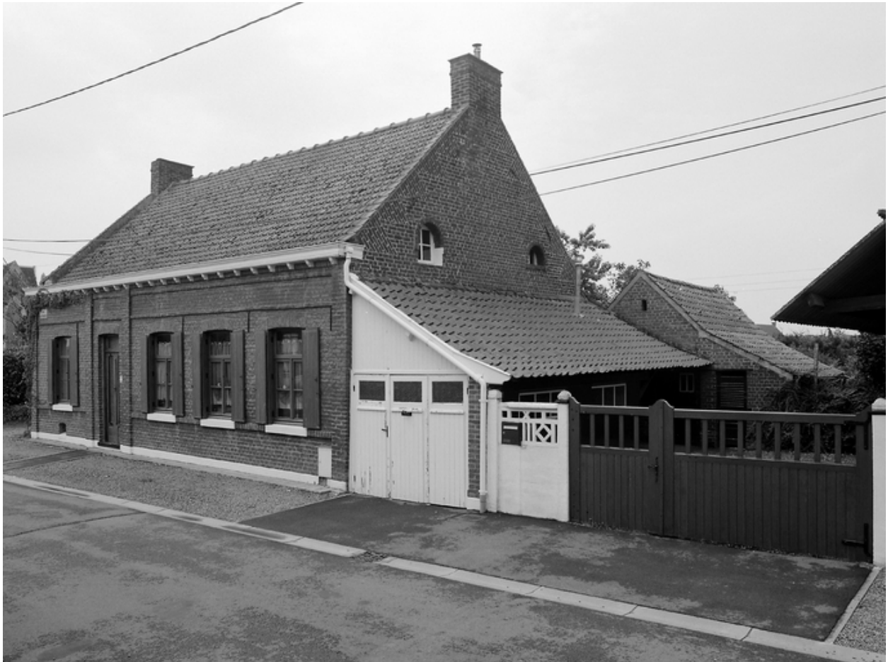
Vue générale de trois quarts : élévation antérieure maison, garage et bergeries.
