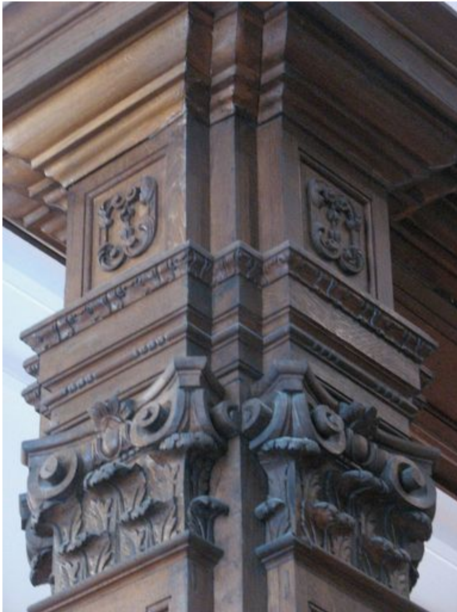
Salle de lecture, vue partielle
