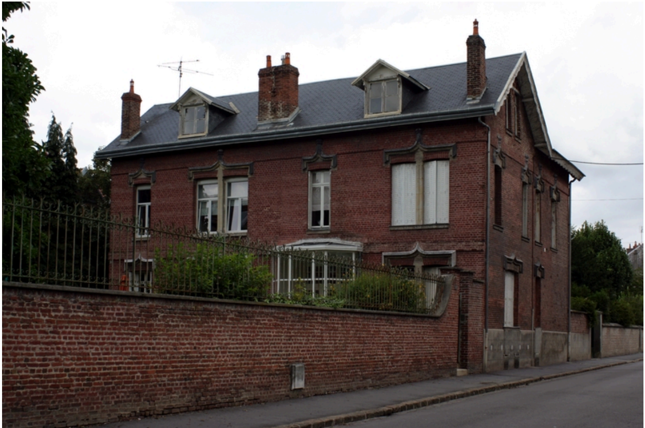
Façade antérieure du logement patronal.
