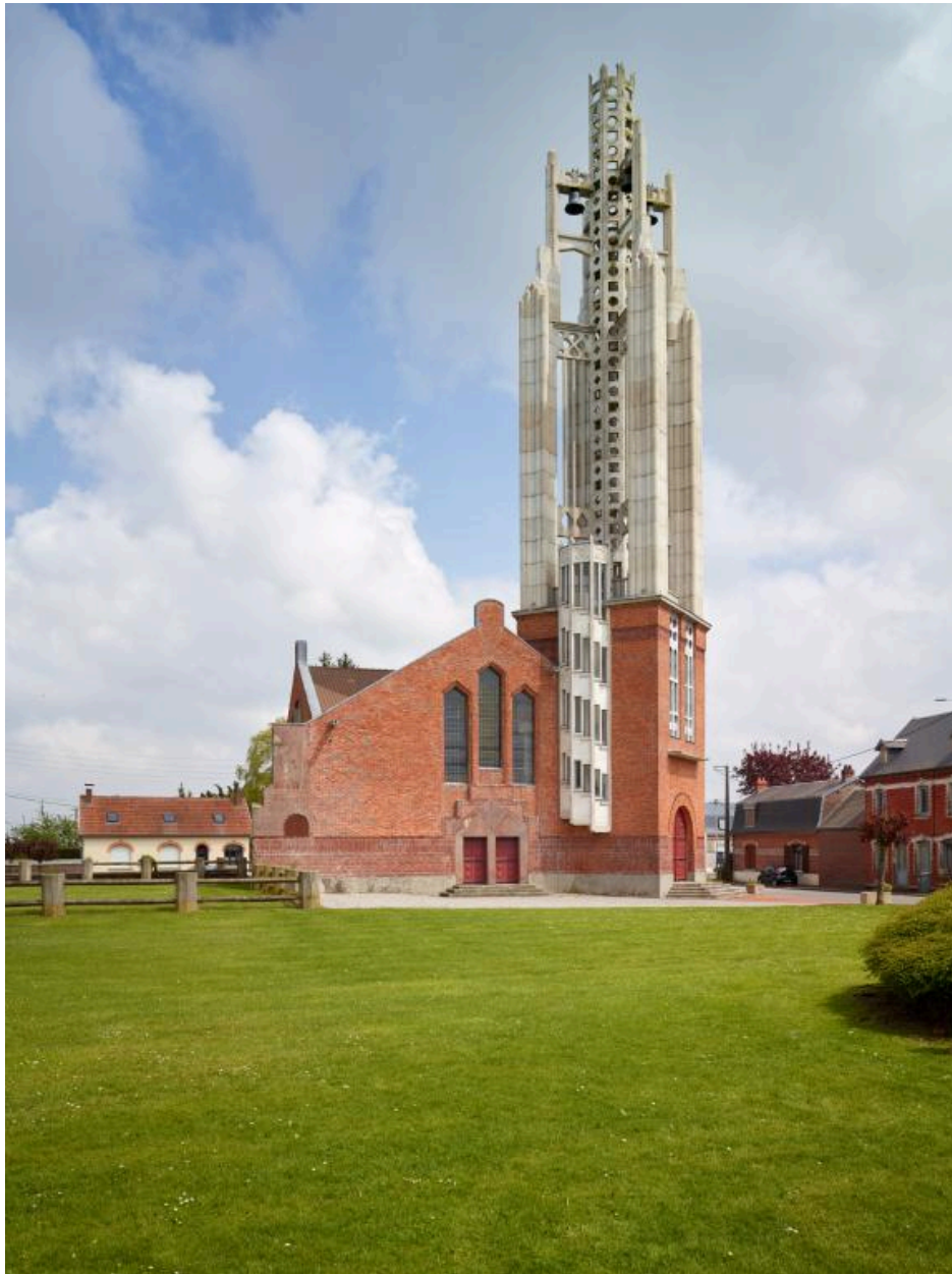
Vue de trois quarts vers le nord-est.
