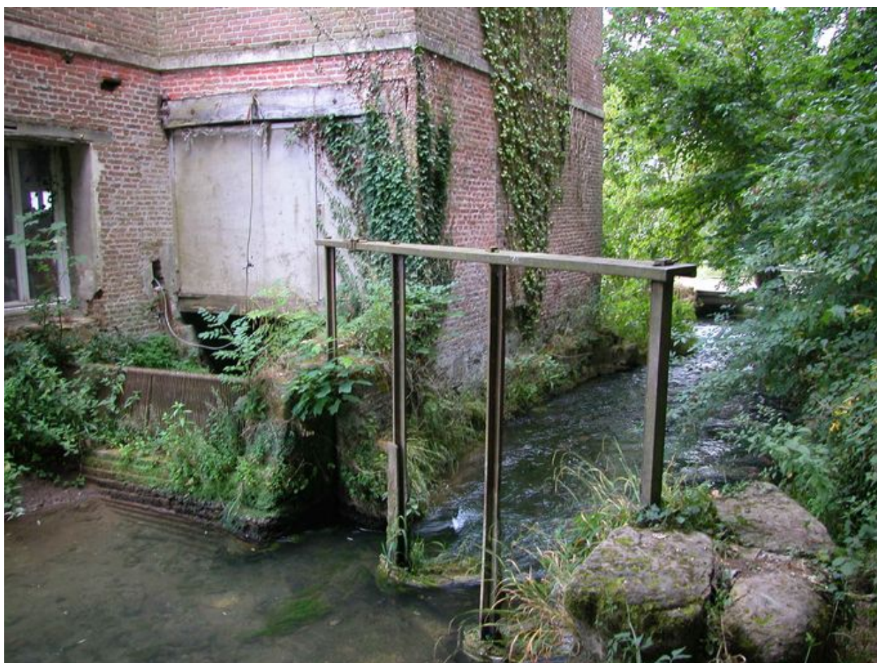
La coulerie et le vannage de décharge.
