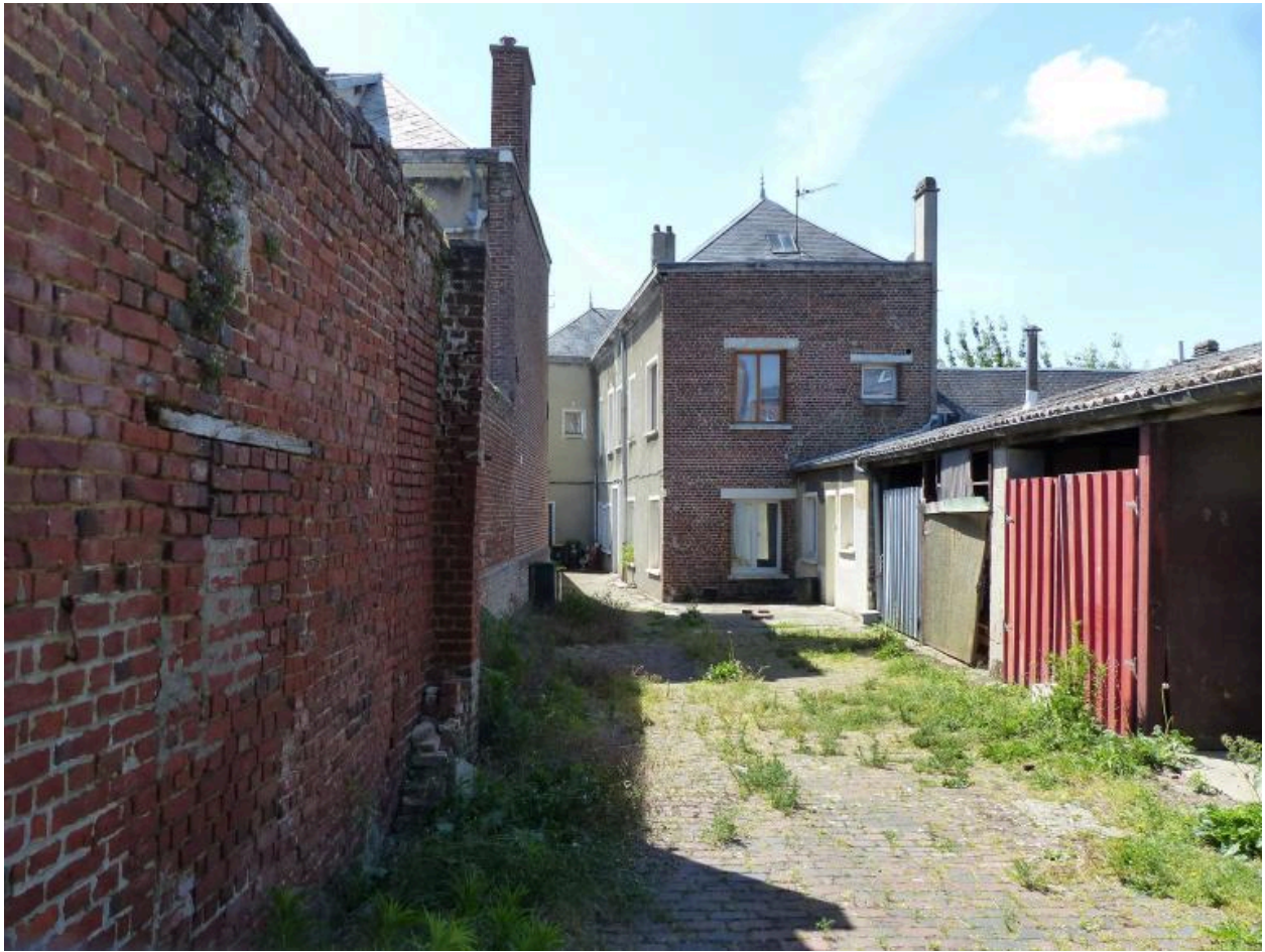
L'ancienne fabrique, vue depuis l'impasse au nord.
