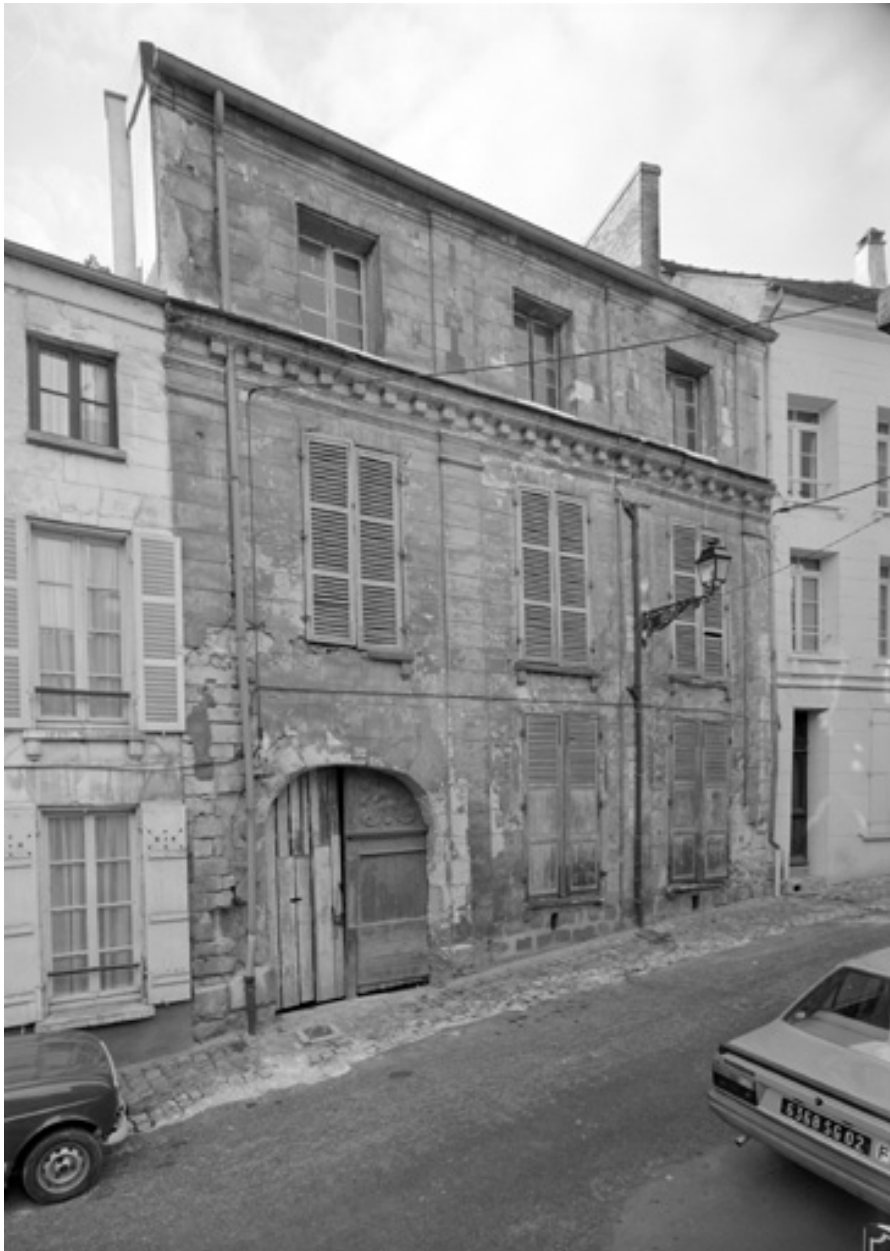
Vue de la façade sur la rue.
