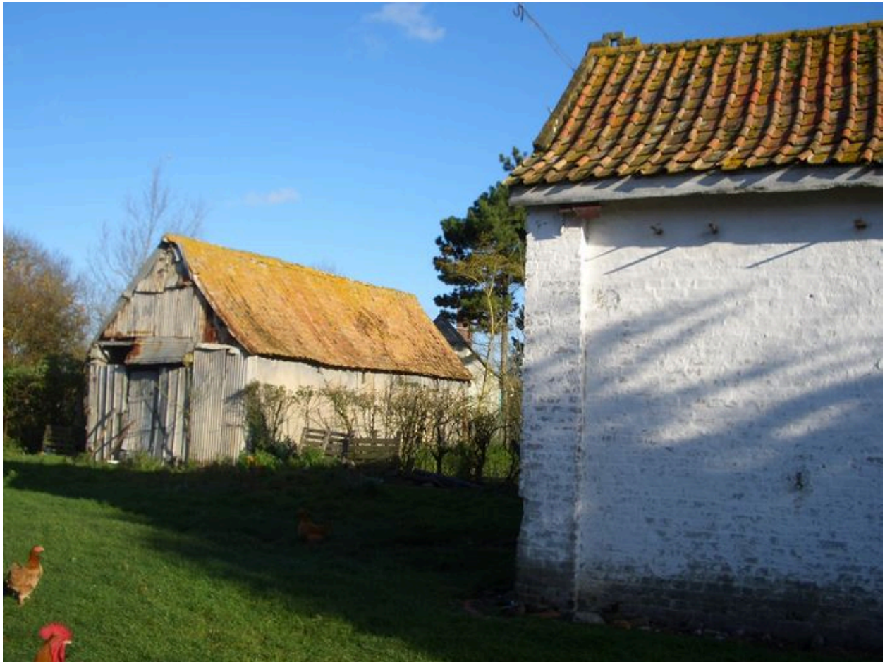
Vue de la grange.
