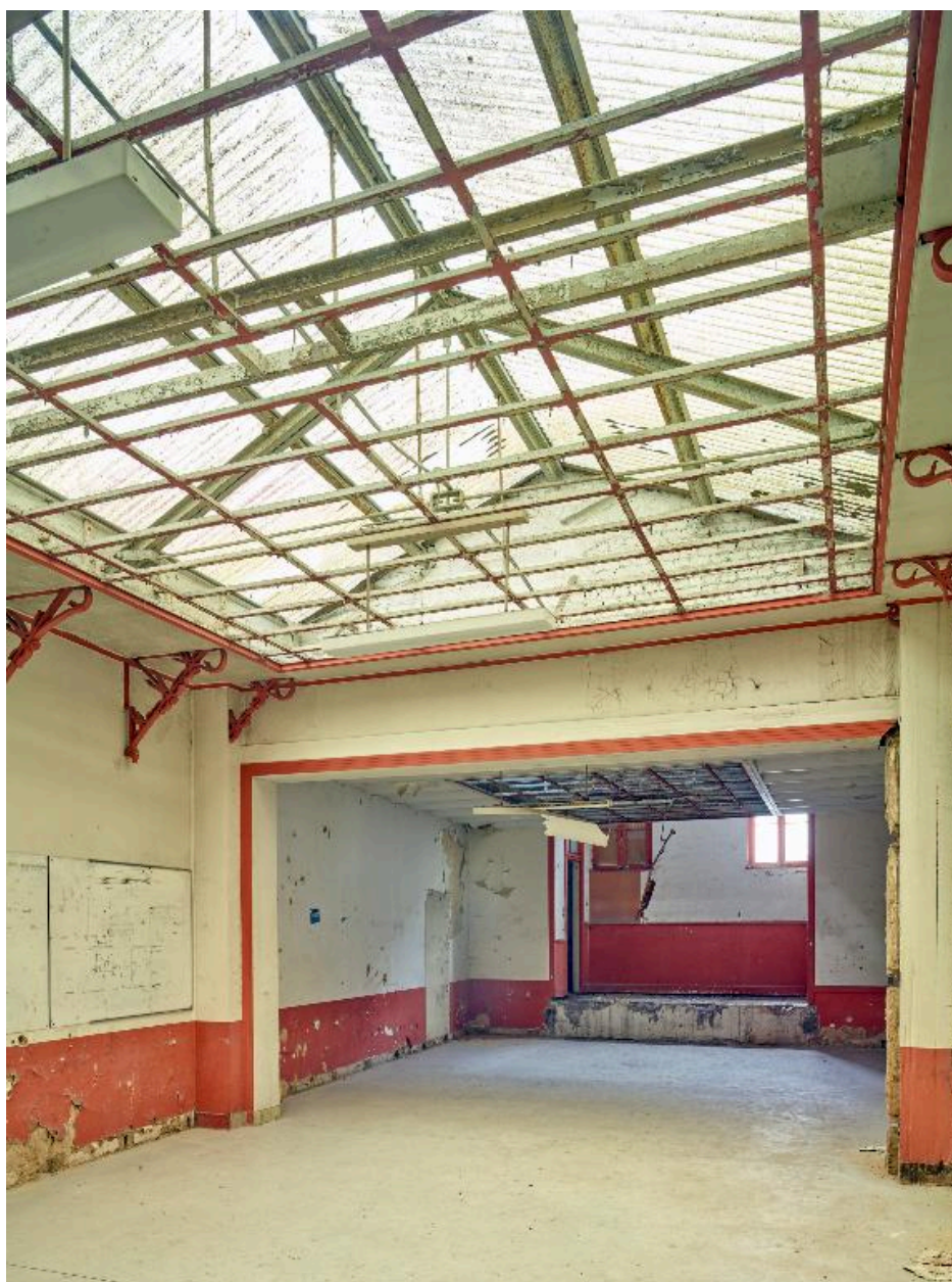
Bâtiment technique, rez-de-chaussée. Vue vers l'est.
