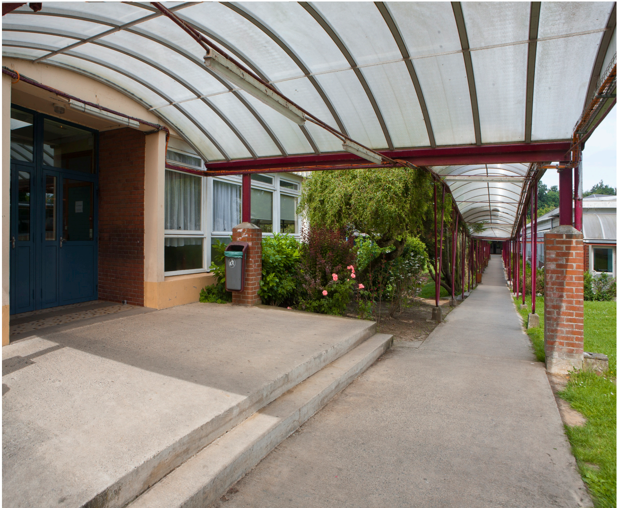
Galerie : jonction avec l'internat de filles (lycée), 2016 (détruit en 2017).
