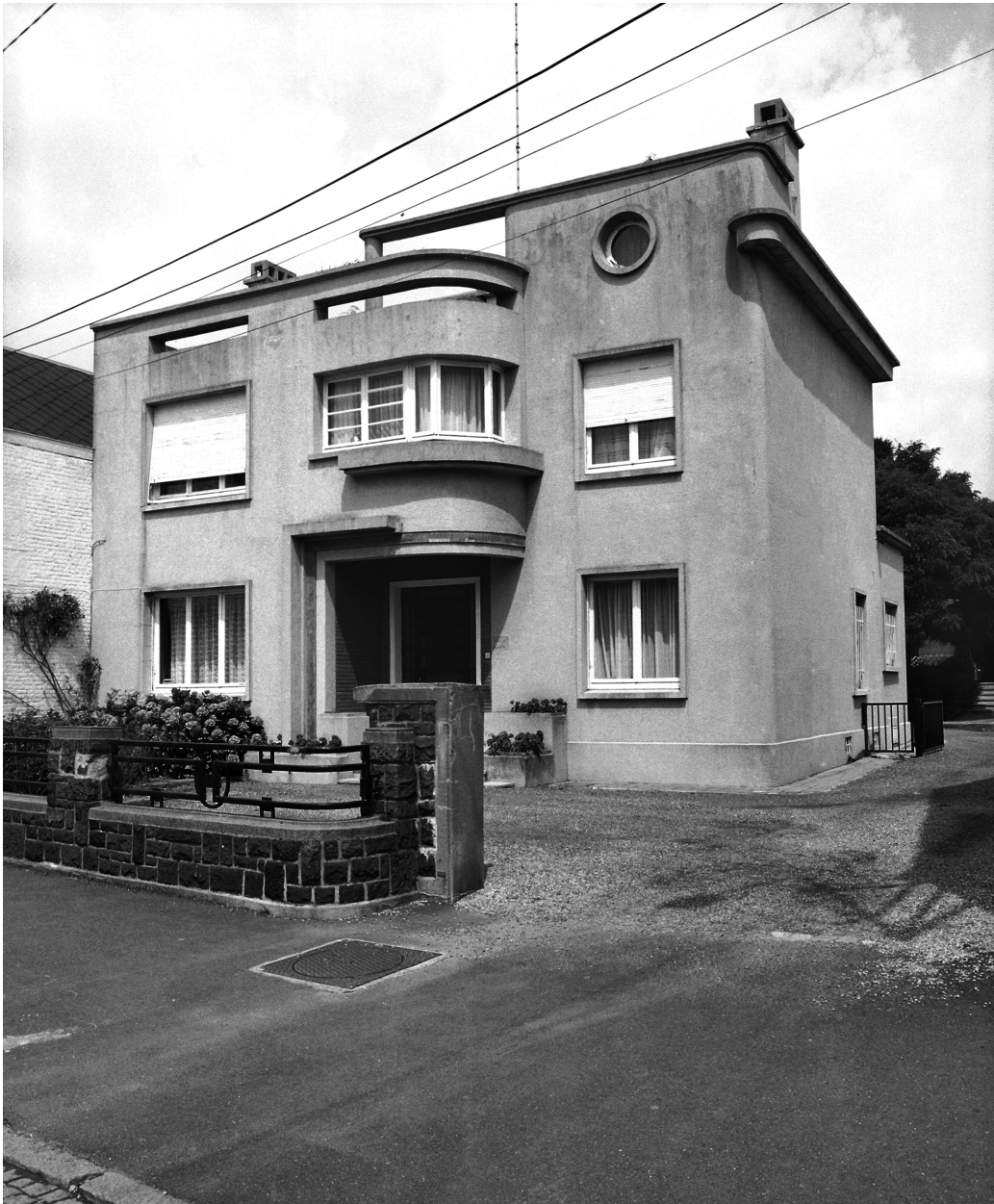
Vue générale de la maison, après sablage.
