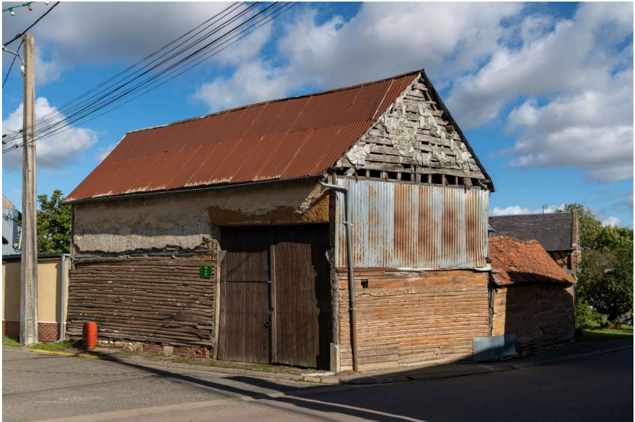
Grange sur rue, n°15 rue de Breteuil, vue depuis le sud-ouest.
