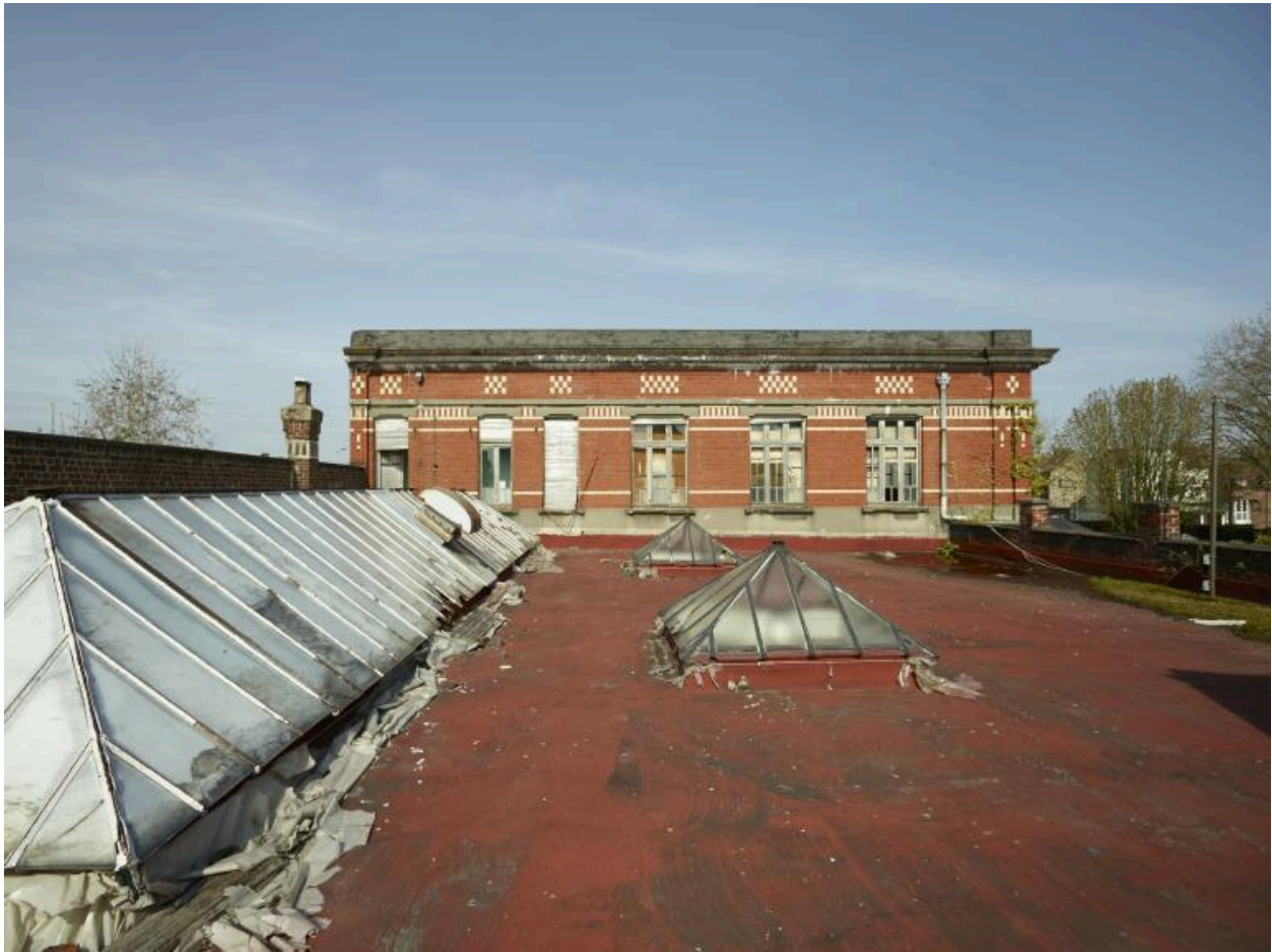
Bureaux. Couvrement. Vue prise vers l'est.
