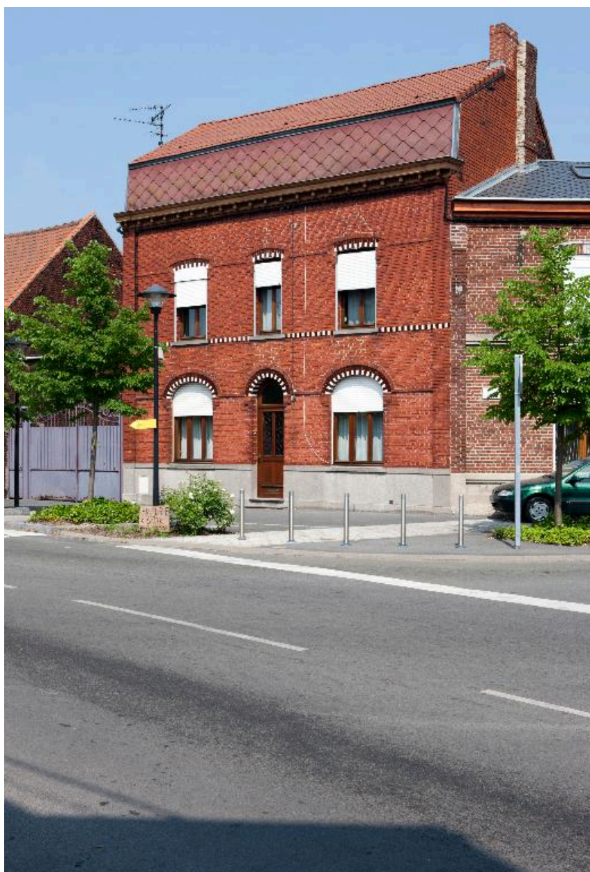
Une maison de bourg, rue de Fresnes.
