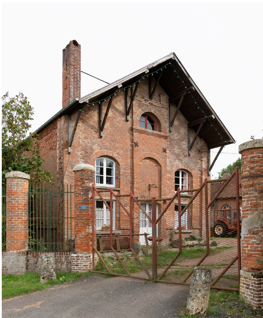
Entrée de l'ancien atelier depuis le nord-ouest.
