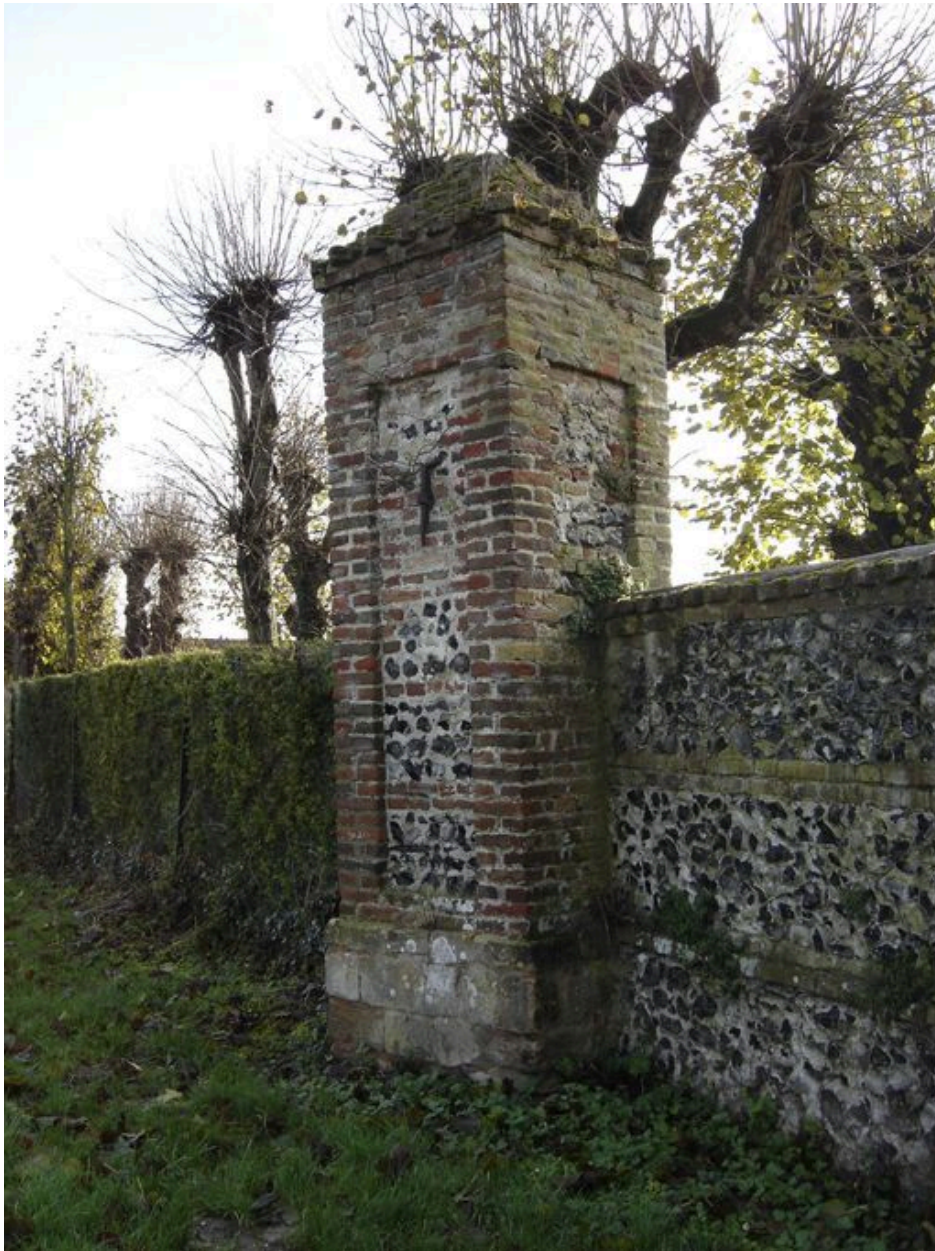
Vue détaillée d'un pilier du mur de clôture.
