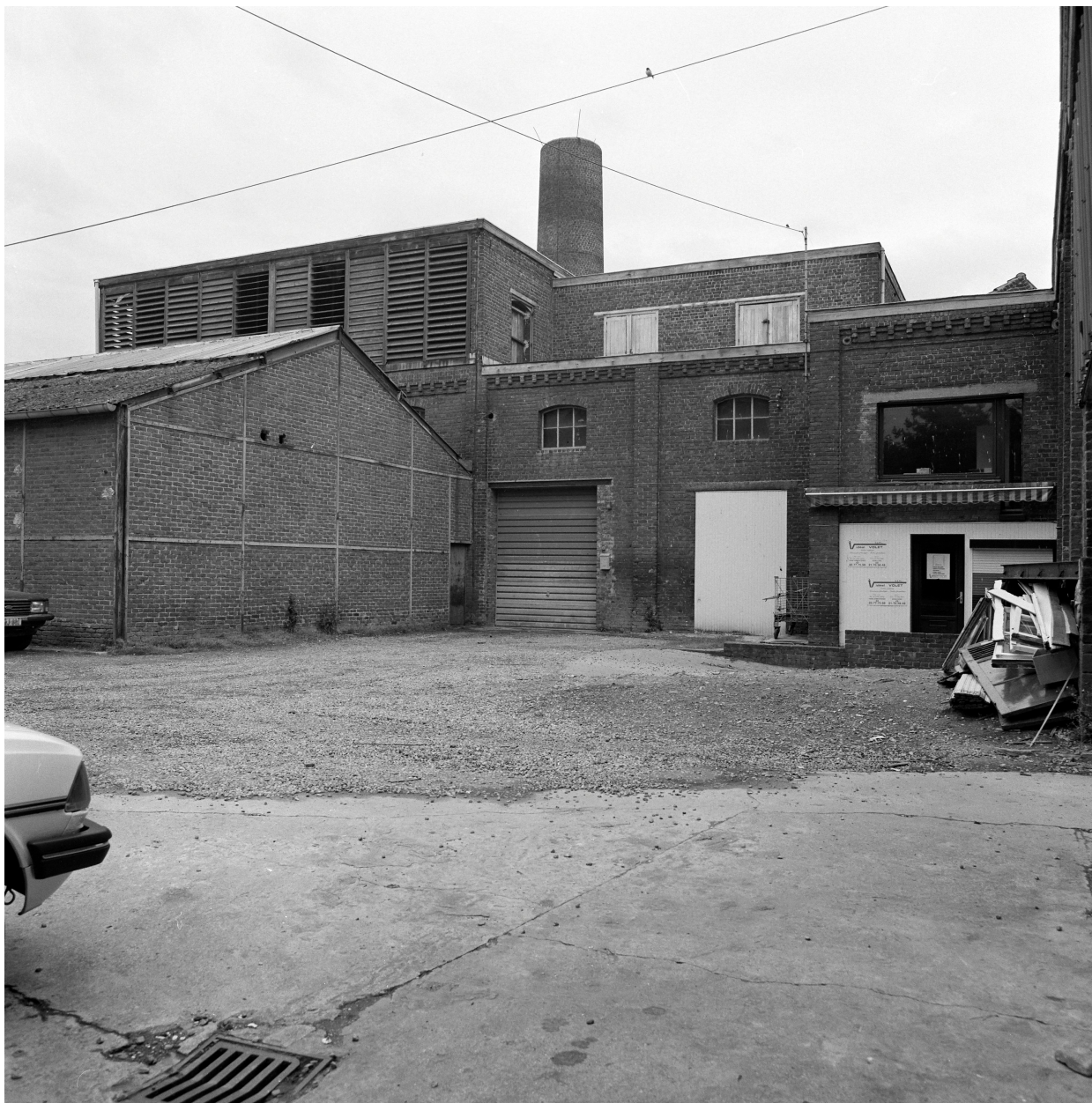
Vue générale vers le sud depuis la cour. À gauche, la pièce de séchage. Au centre l'ancienne chaufferie.
