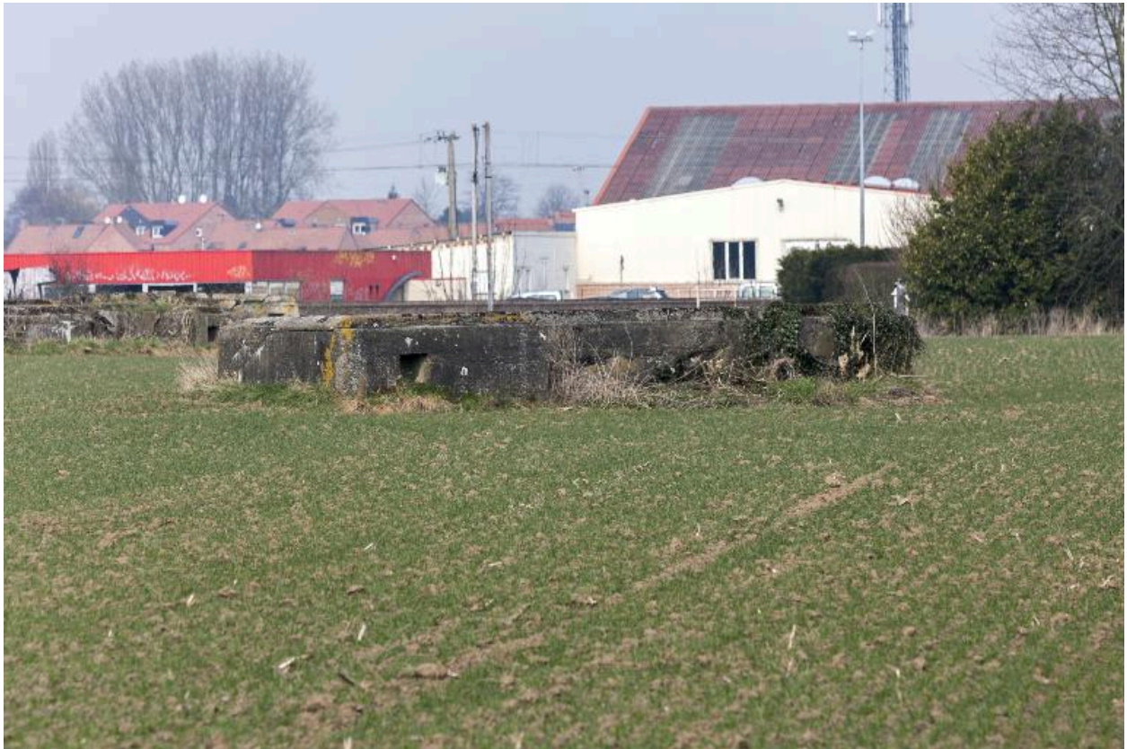
Ouvrage en U.
