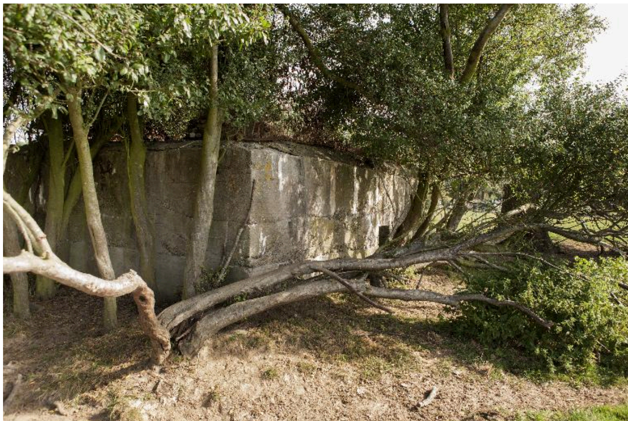
Élévation sud, vers le nord-est
