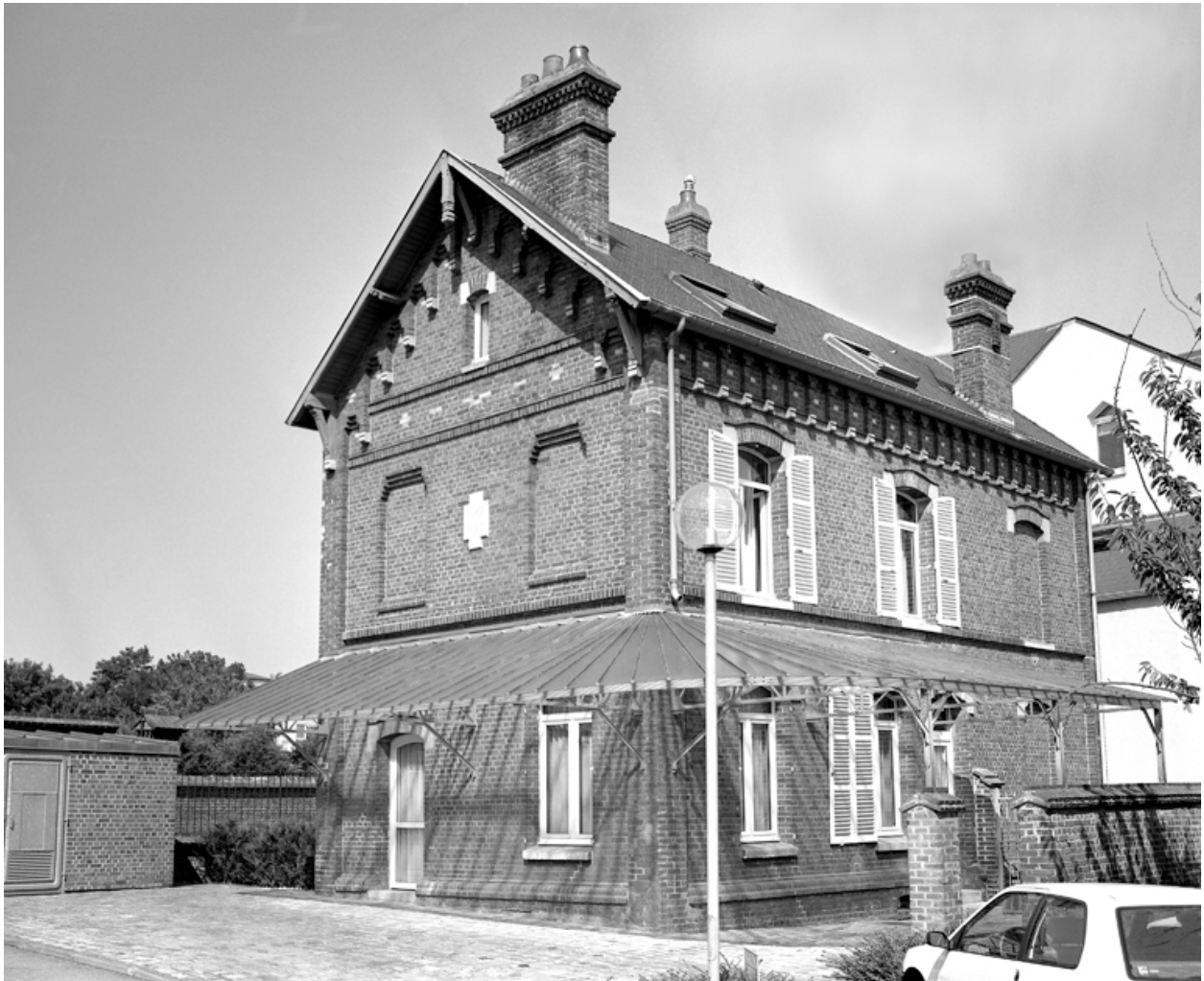
Le logement du contremaître.
