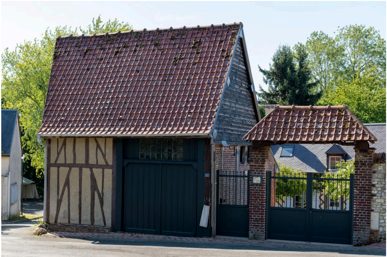
Ancienne grange sur rue avec entrée charretière, n°22 rue Pauvrette, vue depuis le nord.
