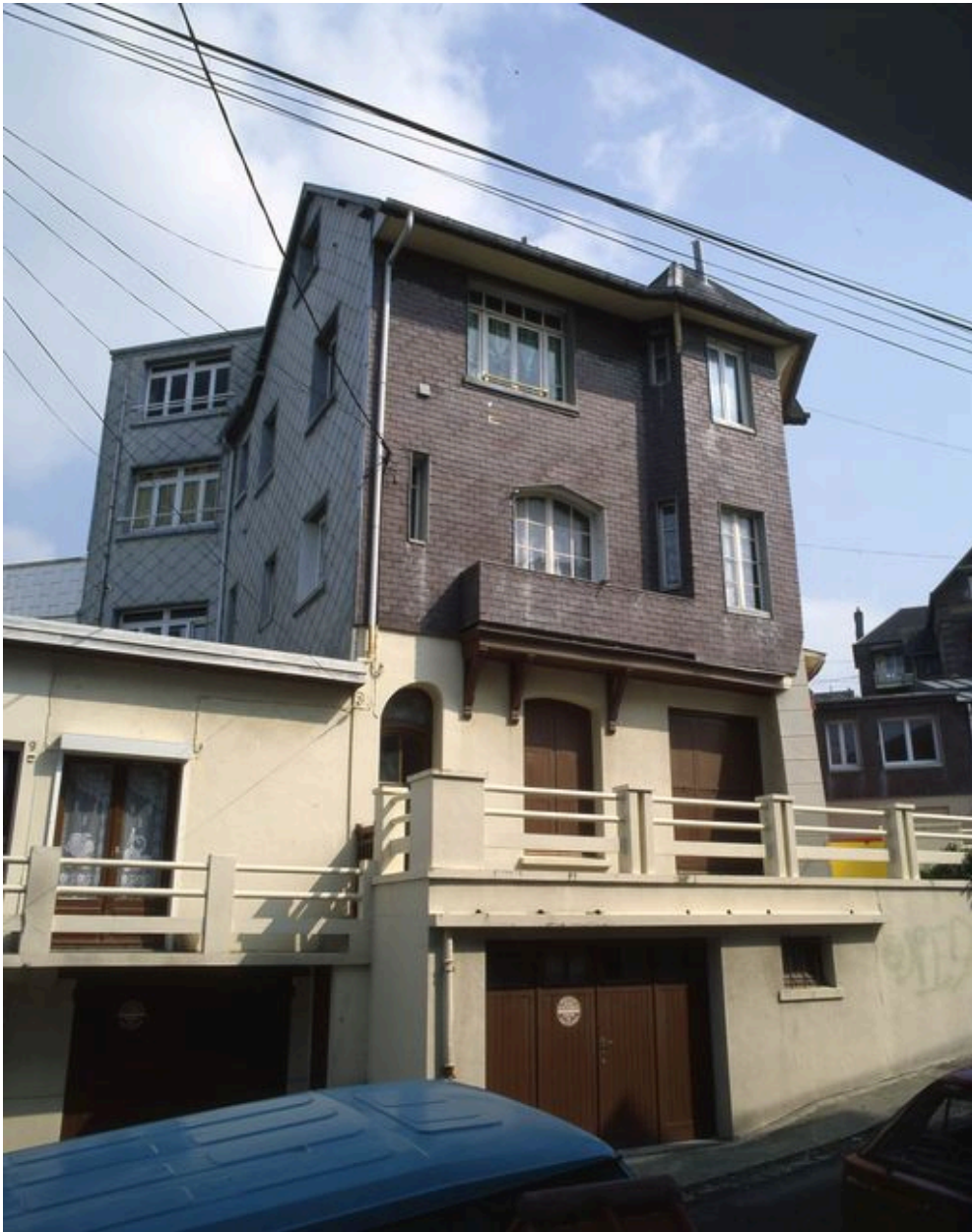
Vue de trois-quarts sur les façades latérale gauche et postérieure.
