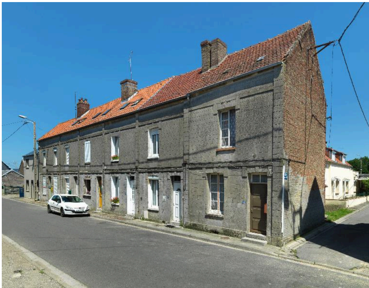
Cité ouvrière, rue Joliot-Curie.
