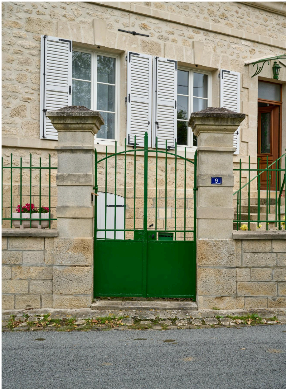
Portillon de la maison, vue sud.
