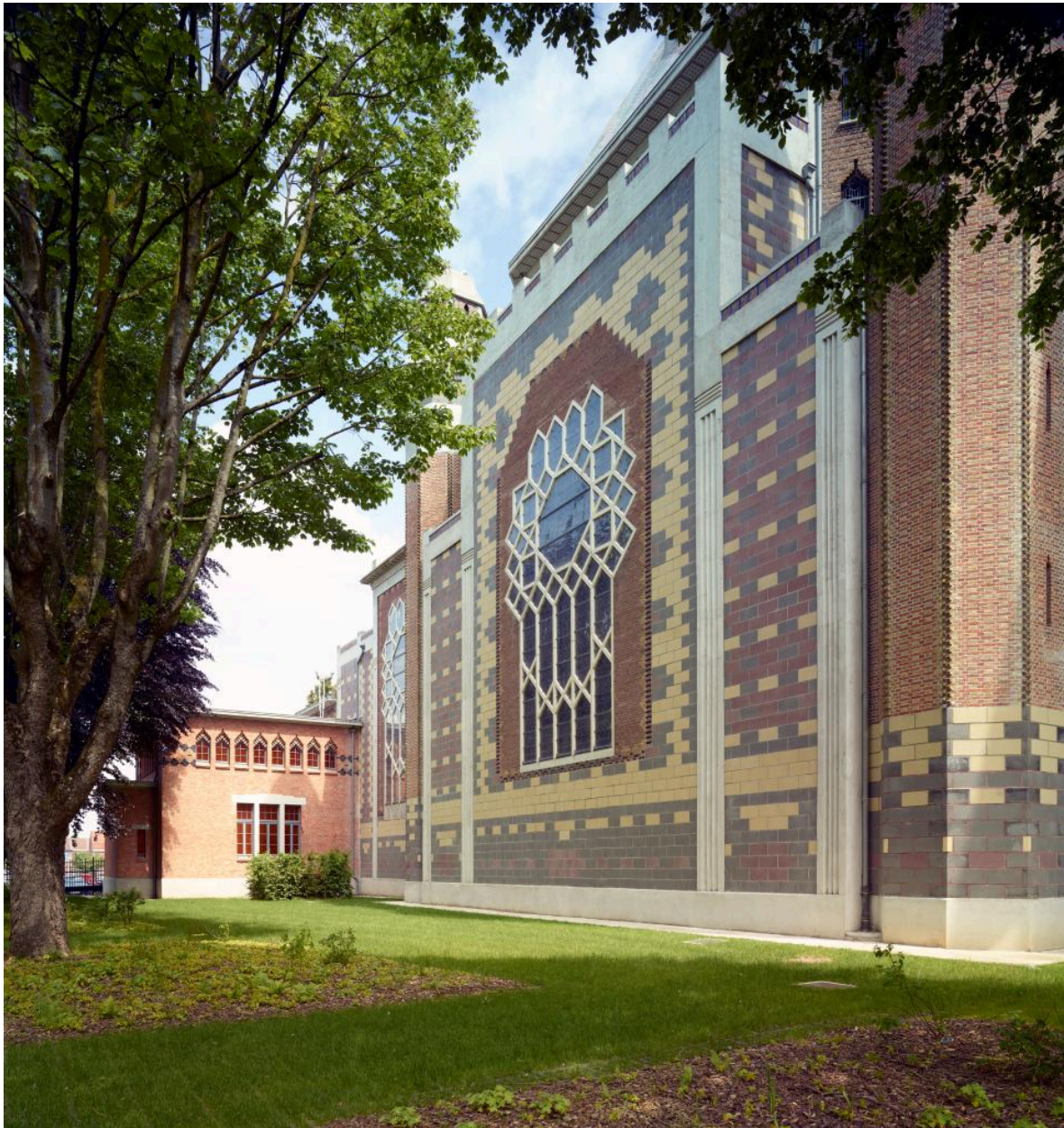
Façade nord, depuis l'angle nord-ouest.
