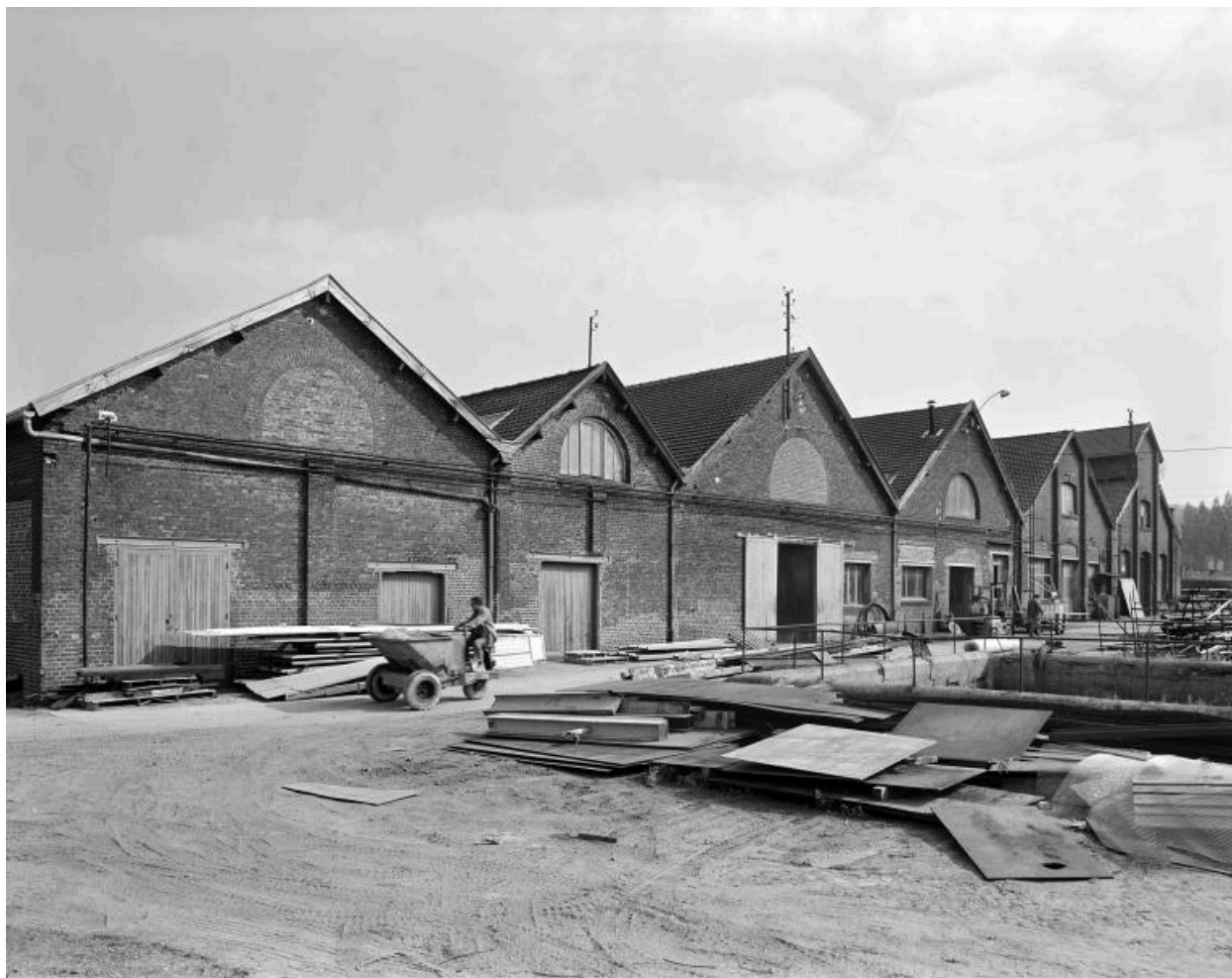
Vue extérieure des bâtiments industriels.
