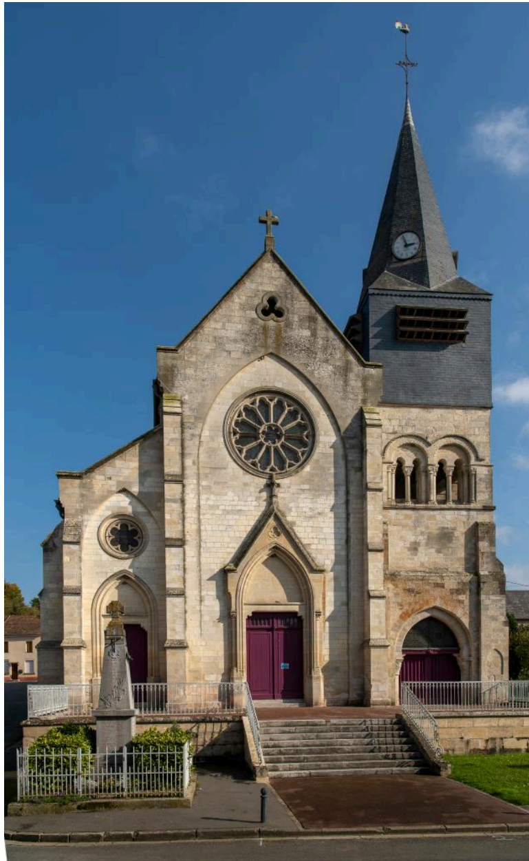
Vue générale de la façade occidentale.
