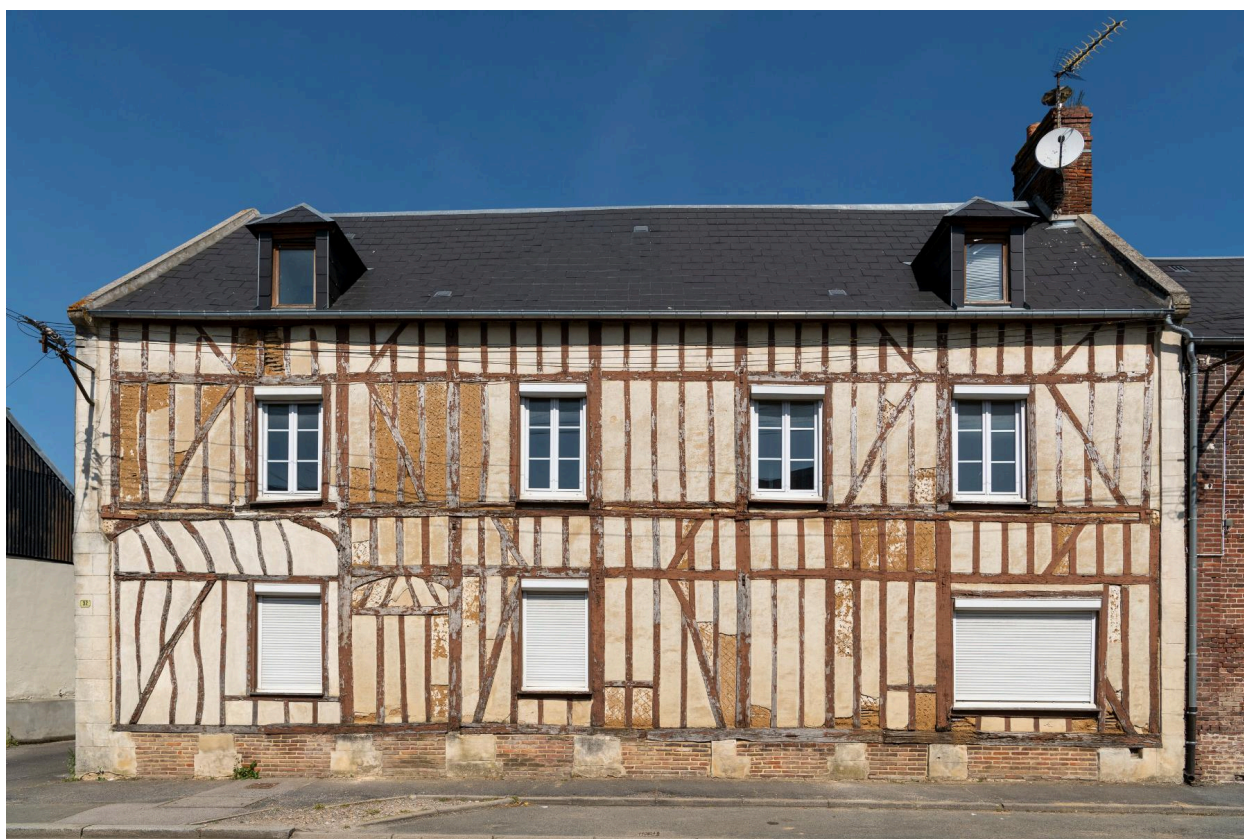
Logis sur rue avec pan de bois apparent, n°32 rue de Beauvais, vue prise depuis l'est.
