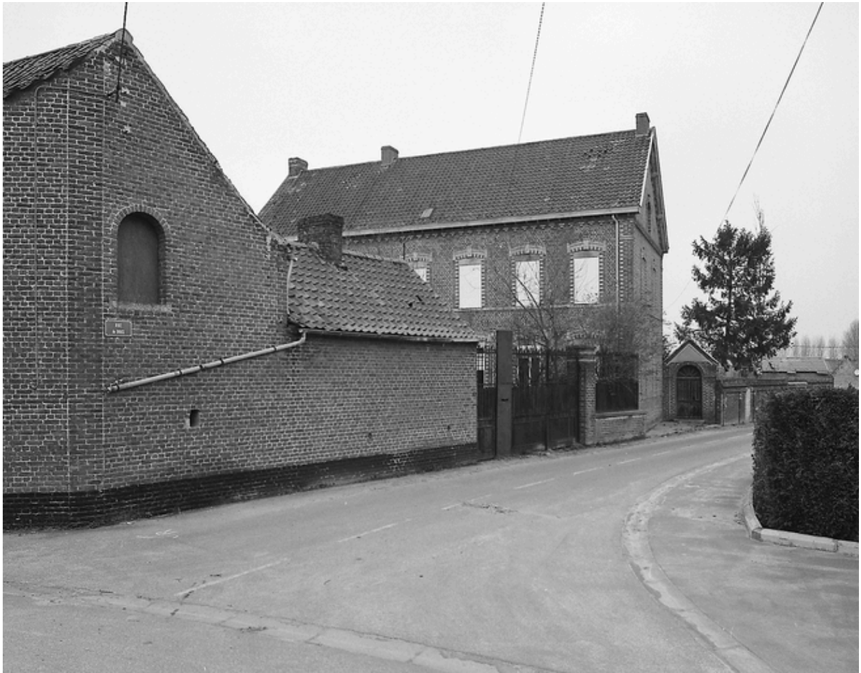
Ferme à cour ouverte, 80, rue du Bois, vue générale depuis la grange.
